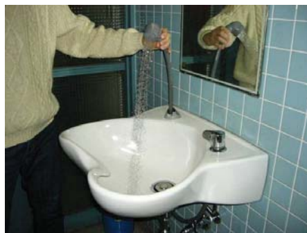
図 3 緊急シャワー（トイレに設置）
