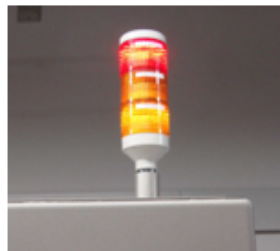
図3 外部照射ランプ
