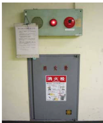
図4 火災報知器（上）と消火栓（下）
