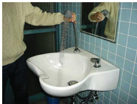
図 3 緊急シャワー（トイレに設置）
