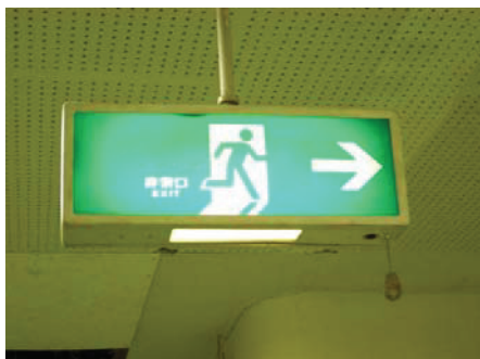
図 2 避難経路を示す誘導灯
