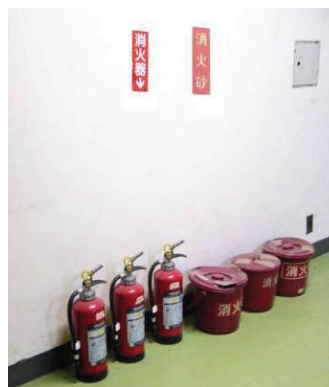
図5 消火器と消火砂
